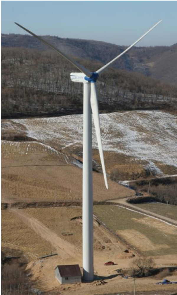
유니슨 2MW 풍력발전기
